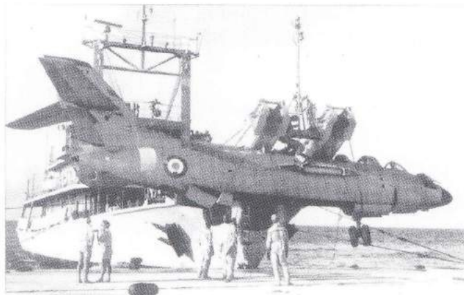
Fin des avions VAUTOUR à HAO, on démonte, on charge sur la gabare de mer TIANEE, puis on immerge.
